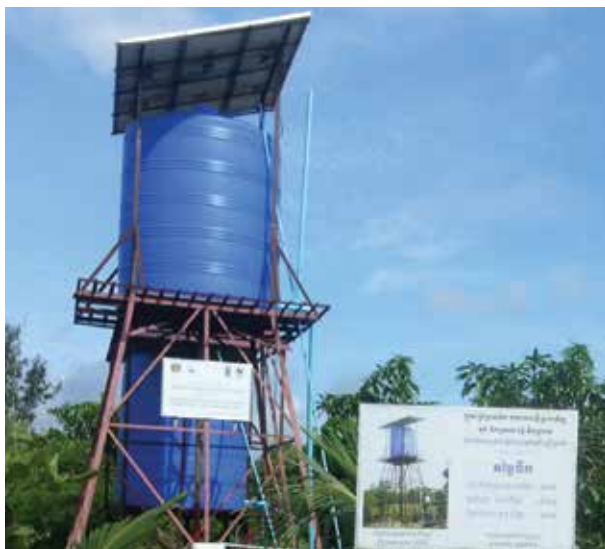
ប្រព័ន្ធបូមទឹកដោយថាមពលពន្លឺព្រះអាទិត្យ នៅឃុំទឹកក្រហម ខេត្តព្រះវិហារ
