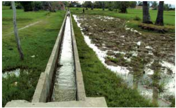
រូបភាព៖ ការស្រោចស្រពស្រែដោយប្រើប្រាស់ប្រលាយបេតុង
